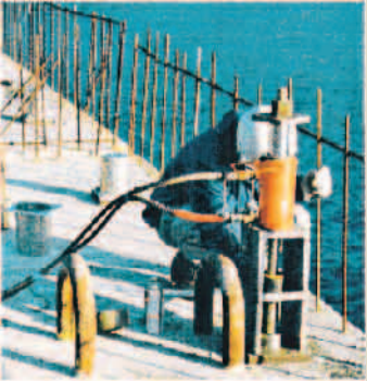
緊張作業状況
