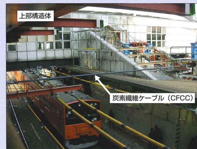
CFCC架設状況
