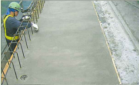
●上塗り樹脂モルタル塗布状況
