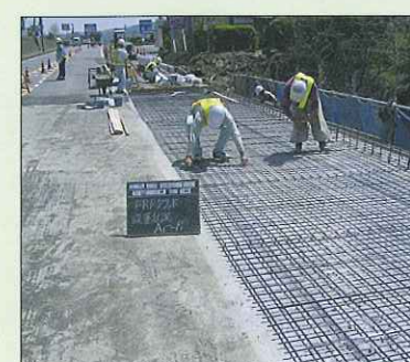
●CFRP製ネフマック配置状況
