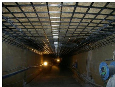
ネフマックによるサイフォンの補修補強状況
