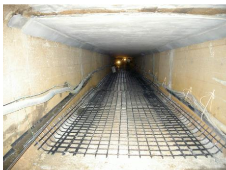
ネフマックによるサイフォンの補修補強状況
