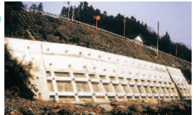
グラウンドアンカーは工場組立と現場組立のものがあります。(形体は一例)
