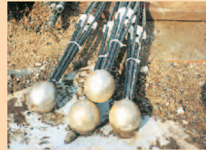
グラウンドアンカーは工場組立と現場組立のものがあります。(形体は一例)
