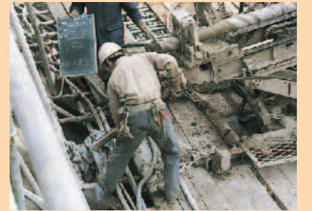
グラウンドアンカーは軽いので、挿入が比較的容易です。
