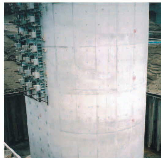
▲テクノラッド緊張材設置状況
