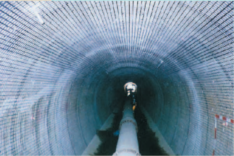
▲ ネフマック取り付け後の状況
