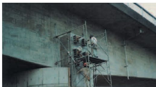
▲変位制限装置テクノラッド緊張状況
